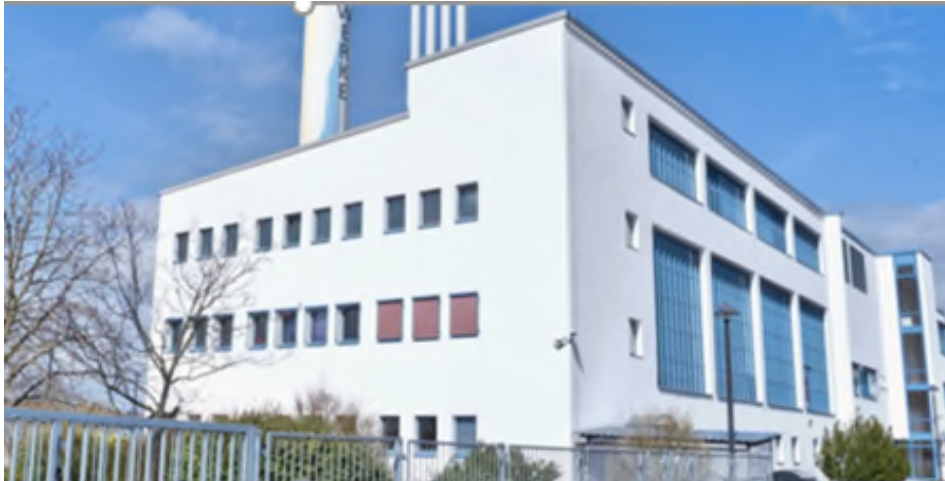
BHKW - Berliner Straße
