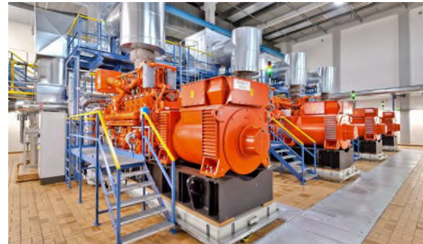
4 neue, leistungsstarke Waukesha-Module (Investitionsvolumen: 8,5-Millionen Euro)
