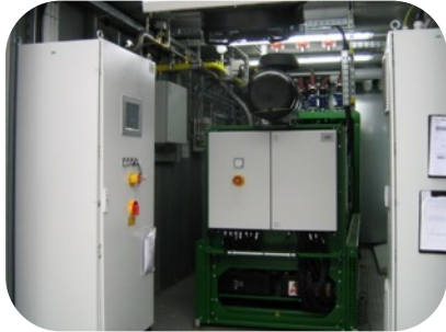
agenitor 306 SG im Container. Projekt: TOTAL Wasserstoff Service Station am BER Flughafen in Berlin
