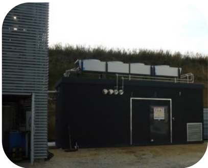
agenitor 306 SG in Betonschallhaube (Synthesegas mit 50% H 2 )
