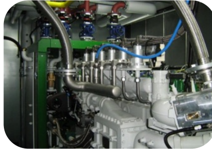
agenitor 306 SG im Container. Projekt: TOTAL Wasserstoff Service Station am BER Flughafen in Berlin
