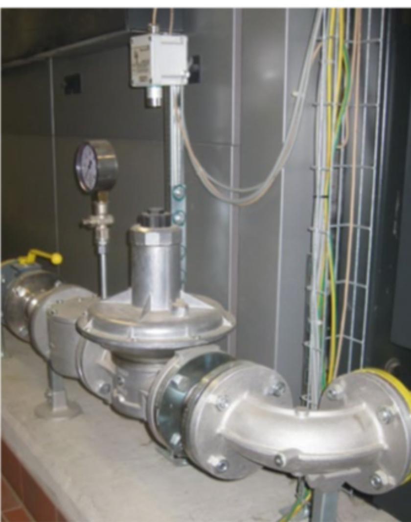
Bei BHKW mit elektrischen Leistungen  $> 50$  kW kann eine ortsfeste Gaswarnanlage zur Erkennung gefährlicher explosionsfähiger Atmosphäre und zur Auslösung von automatischen Schutzmaßnahmen und Notfunktionen eingesetzt werden.
