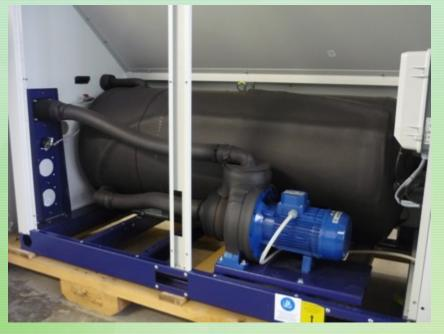
Kältebeständige Isolierung verklebt, anschließend mit Blchmantel umhüllt gegen UV-Strahlung und Nager
