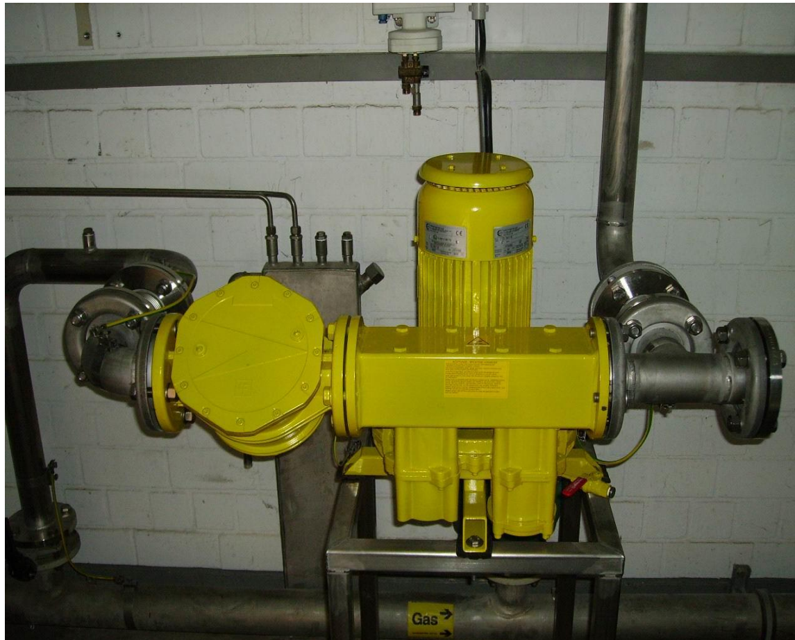
Beispiel: Seitenkanalverdichter mit internem Bypass, Filter und Instrumentierung
