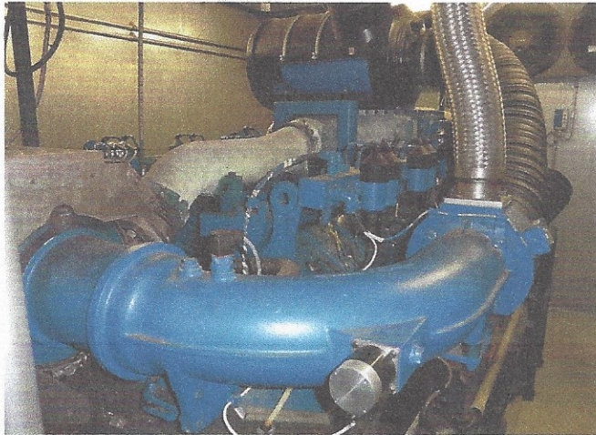
Gemischregler-Stellmotor im Ansaugkanal montiert.
