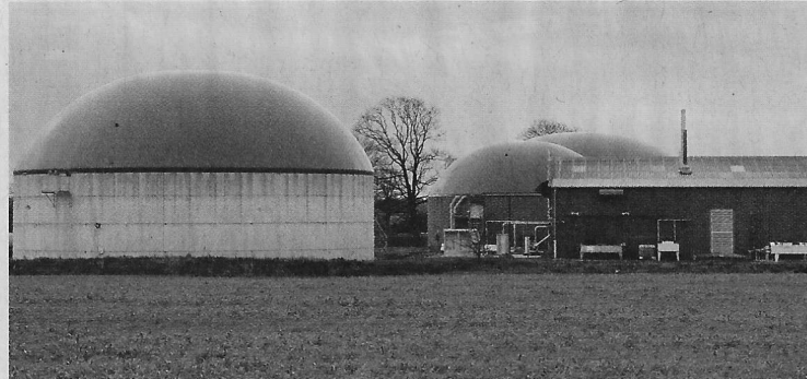
Das neue Gärproduktlager der Biogasanlage in Holtsee sorgt für eine bessere Lagerkapazität. Fotos (4): Sabine Voiges
