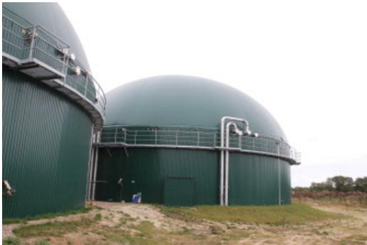
Eine flexible Biogasanlage benötigt ausreichend Gasspeicher für die Zeit, in der das BHKW stillsteht.
